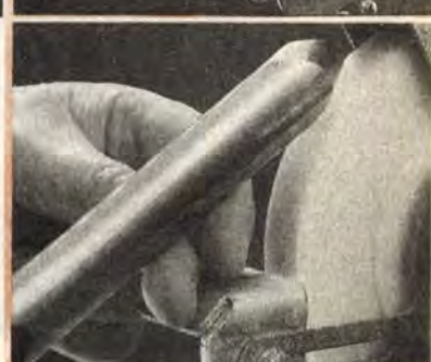
5/i Amint az élszalag a köhöz ér, a kést forgassuk az ívelt felületen és jobb kézzel egy kissé toljuk felfelé úgy, hogy az élszalag megfelelő ivben helyezkedjen el.
